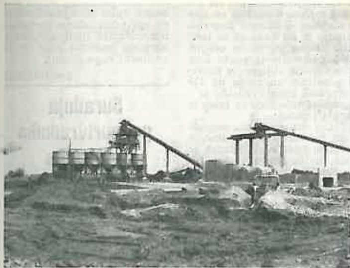
OBIMNI RADOVI NA ŠLJUNCARI
