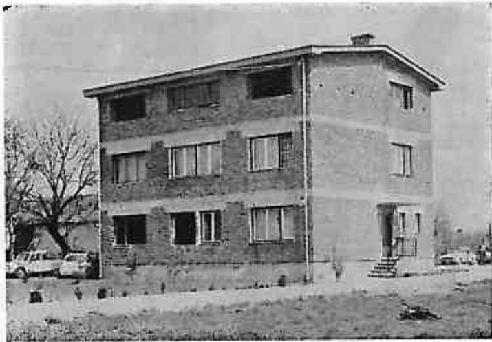
Zgrada veterinarske ambulante u Lupoglavu
