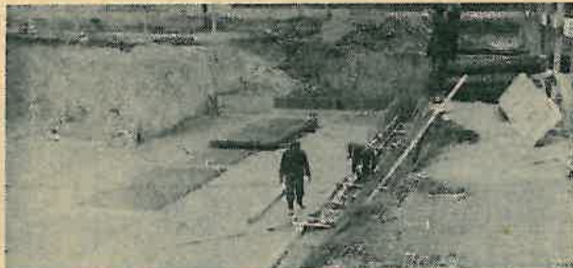
Radovi na podrumu nove zgrade SUP-a
