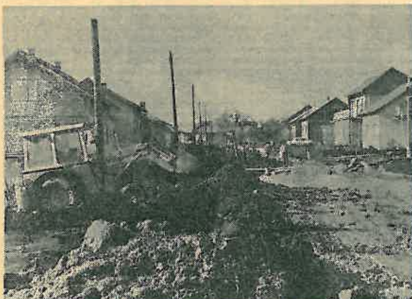
Izgradnja kanalizacije u Novom naselju
