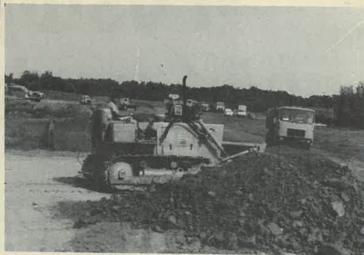
Dvadesetak teških strojeva i kamiona uz nogometno igralište
