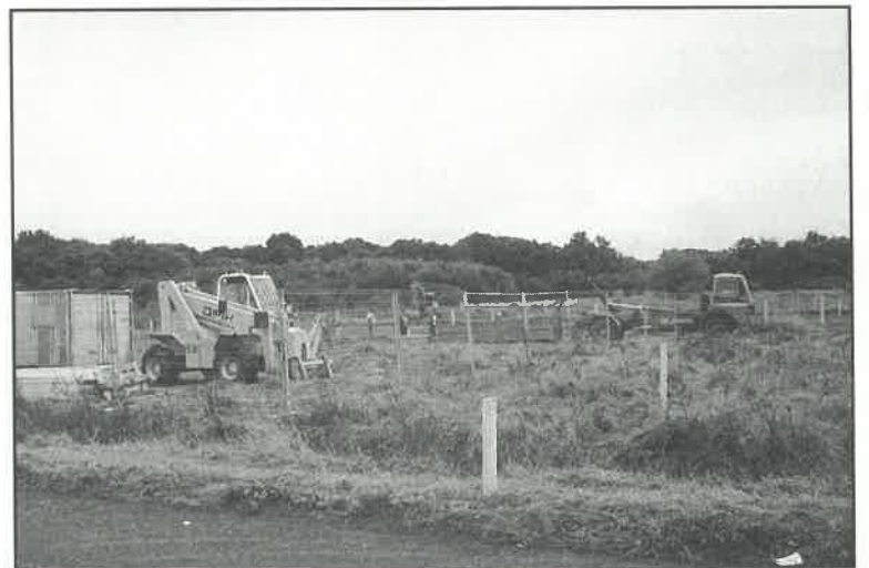
Zemljani radovi na lokaciji buduće srednje škole
