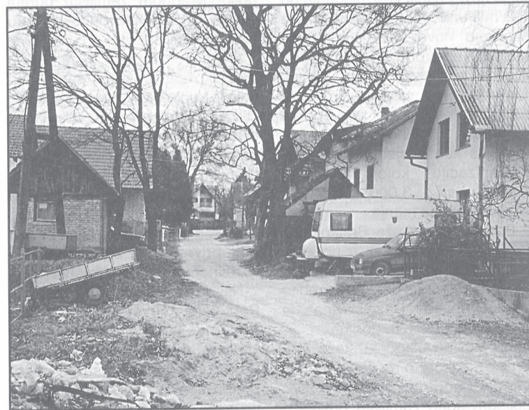
Nekontrolirana, neprimjerena gradnja ozbiljno narušila sklad prostora
