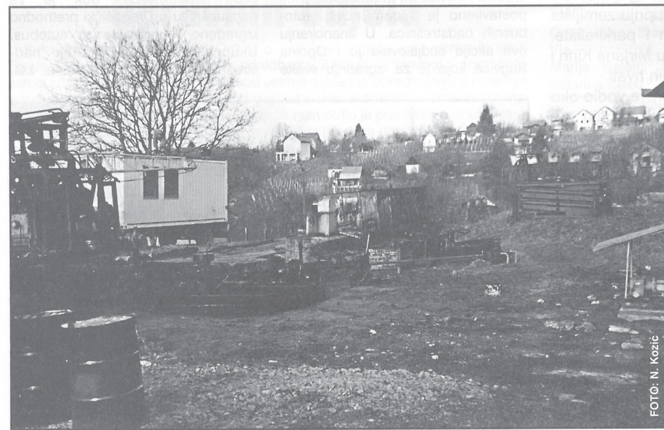
Naftna bušotina na Martinu nakon provedenog remonta
