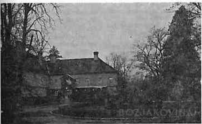
Upravna zgrada državnog dobra Božjakovina , gdje su se odigrali vrlo značajni događaji u kojima će biti riječi u ovom feljtonu
